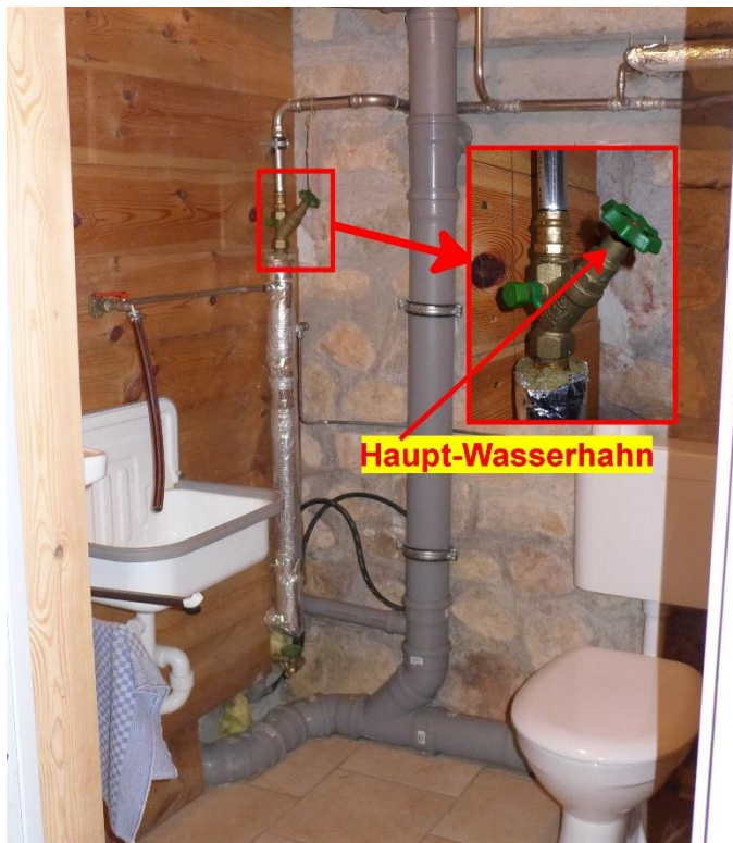
Bild 2: Haupt-Wasserhahn (Keller)
